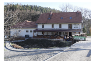
Charakter zástavby: Zemědělská usedlost s rekreačním využitím tvořená budovou bývalého mlýna, stájí a solitérním rodinným domem. Svých charakterem se jedná o objekty stojící ve volné krajině.
