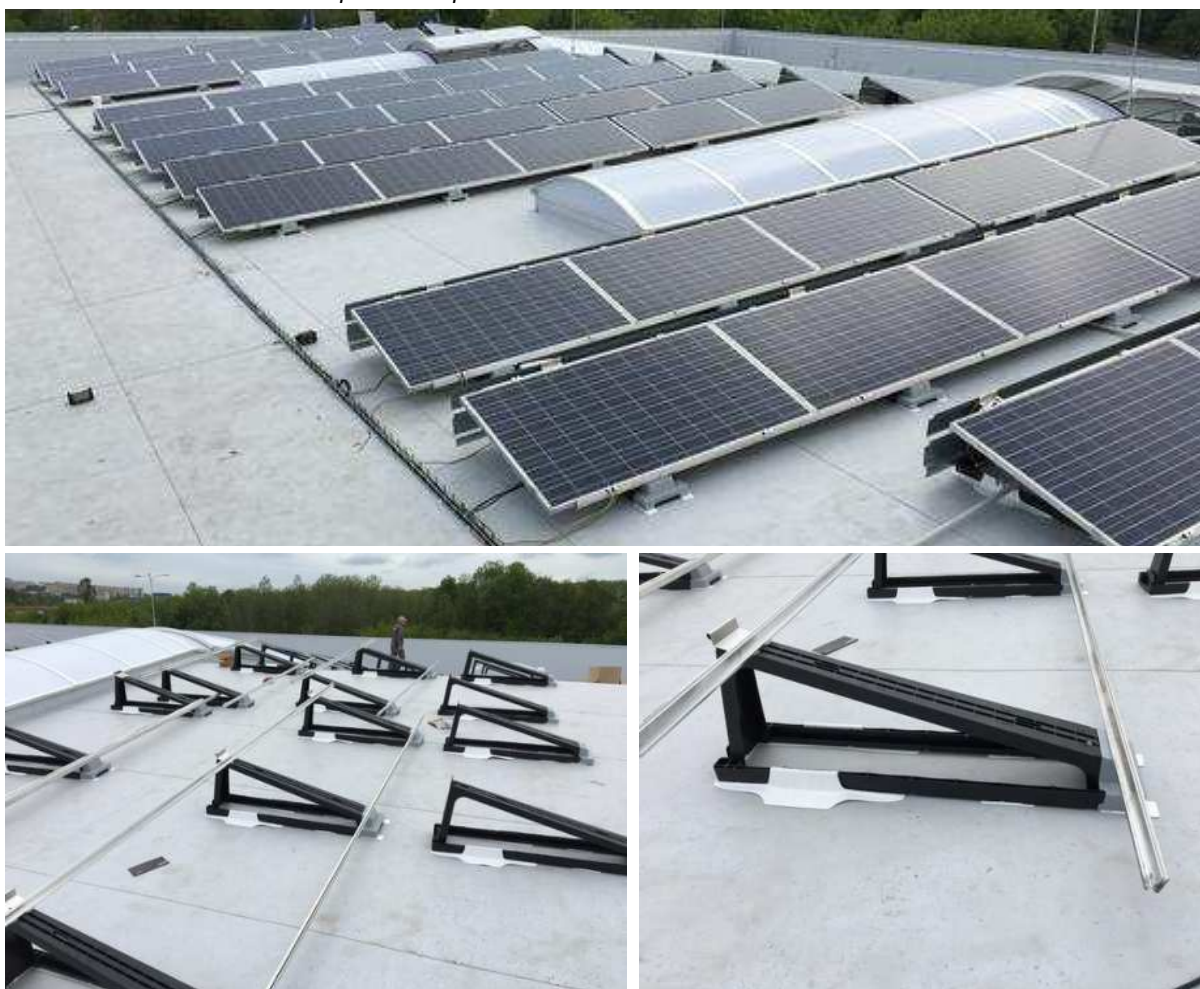
Obrázek 12 Instalace solárních panelů na ploché střeše
