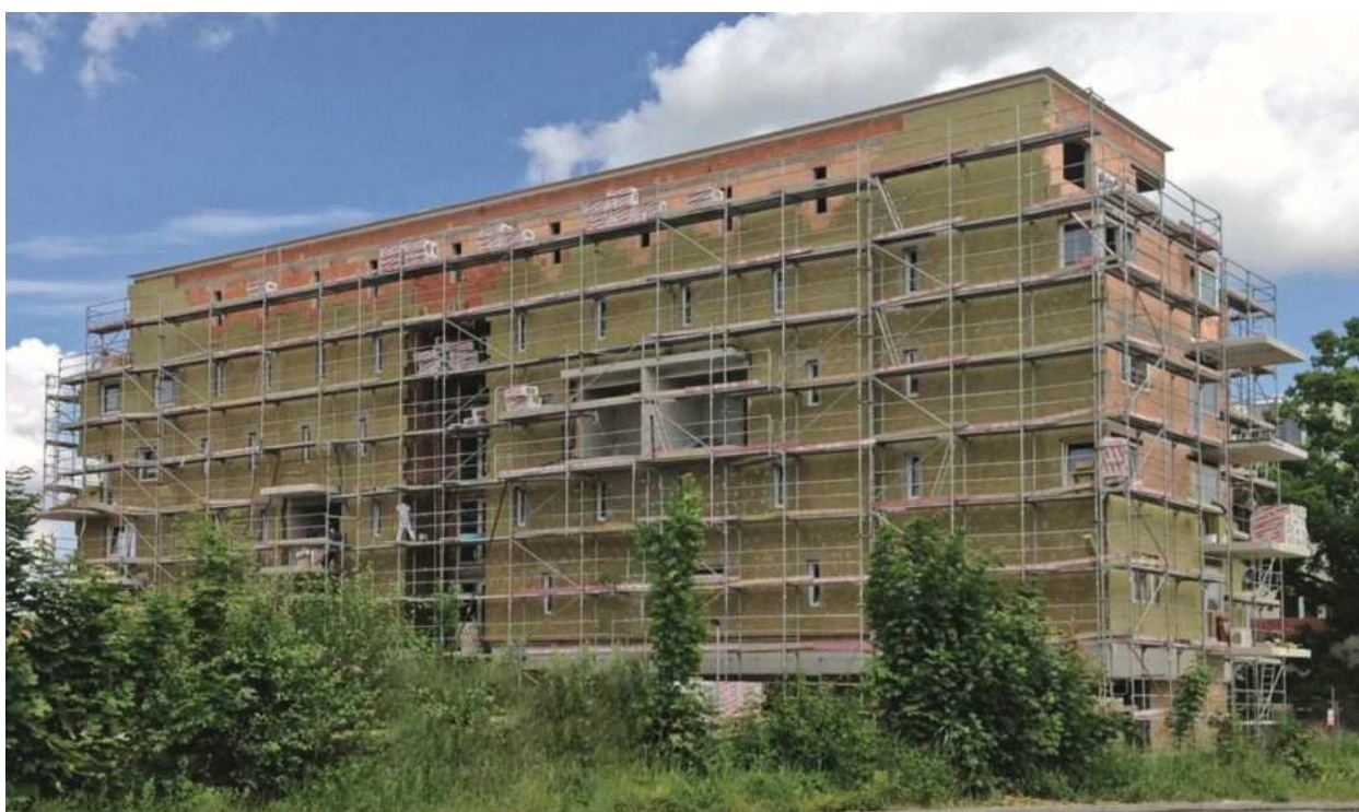
Obrázek 10 Ukázka zateplení fasády minerální vatou
