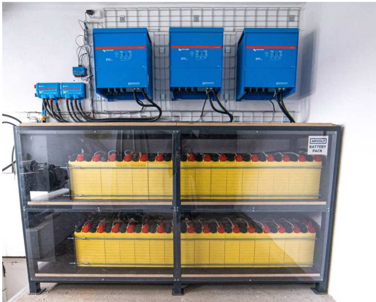
Obrázek 13 Sestava pro solární aplikace, střídače a bateriové úložiště 100 kW
