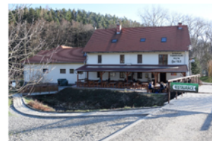
Charakter zástavby: Zemědělská usedlost původně s hospodářským využitím, tvořená budovou bývalého mlýna a stáji. Svým charakterem se jedná o objekty stojící ve volné krajině.
